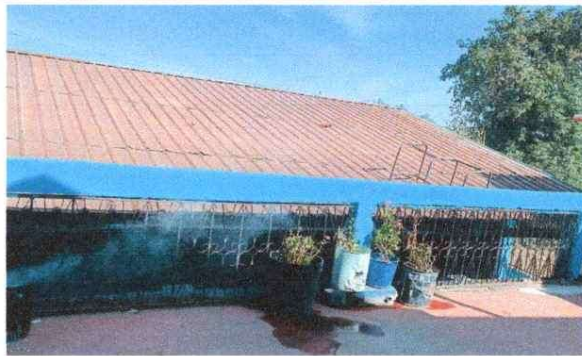
Foto 2: Sustitución de lámina, por lámina troquelada aluzinc calibre 26
